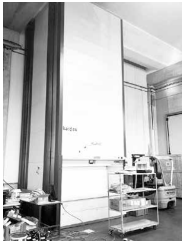
Les nouveaux bâtiments de Froilabo sont entre autres équipés d'un système de stockage vertical Kardex, qui permet d'optimiser la gestion des éléments de fabrication
